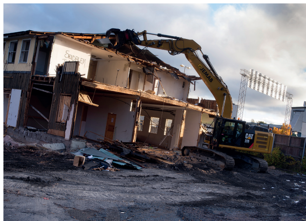
Bild från rivningen av Öringen 15
