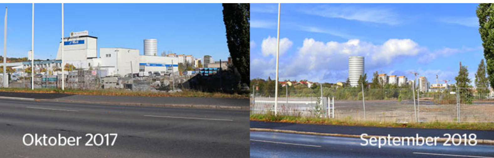
Före- och efterbild på rivningarna i västra Skeppsbron.
