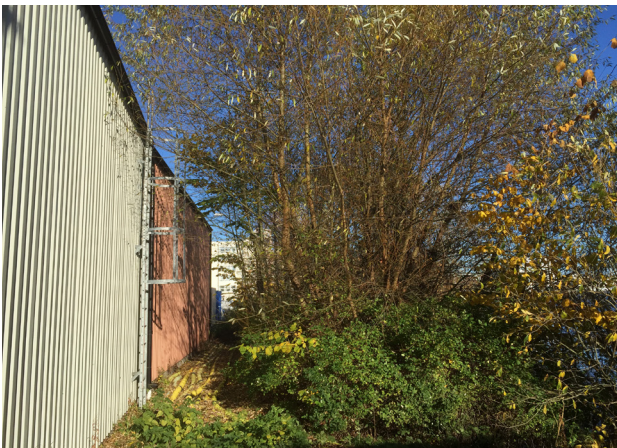
Jönköping Energis byggnad som används som kylcentral
