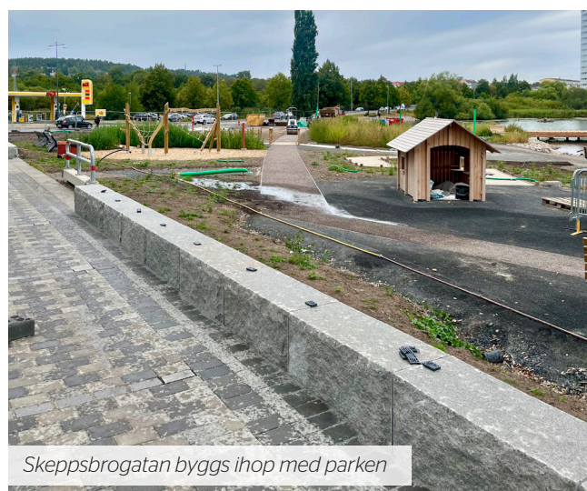
Stenläggningen på Skeppsbrogatan
