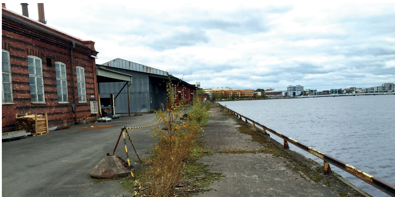
Del av den befintliga Munksjökajen.
