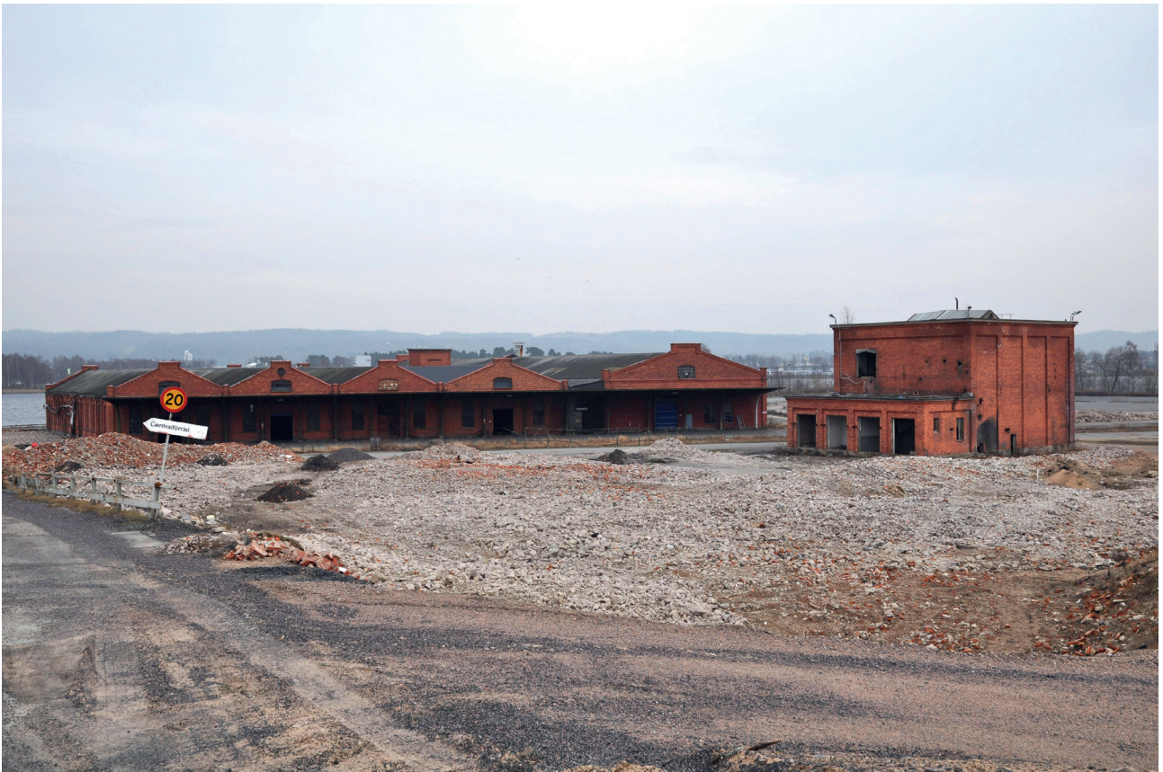
Exploateringsområdet vid Munksjöstaden idag där Säckfabriken och Pannhuset är bevarade.
